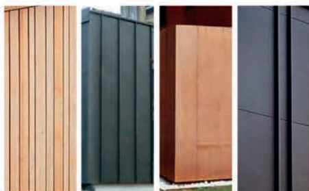
Quelques exemples de bardages contemporains de qualité (bois, zinc prépatiné, cuivre, acier)
