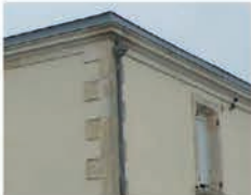
Chaînage harpé et enduit couvrant
