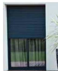
Volet roulant coloré avec coffre intégré à la maçonnerie, identique aux menuiseries (sur façade non visible de l'espace public, ou architecture contemporaine)
