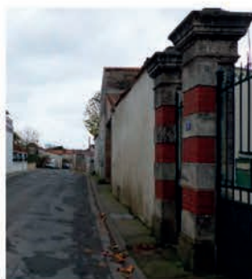
Muret surmonté d'une grille et portail encadré de piliers en pierre de taille et brique
