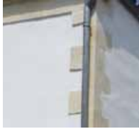
Chaînage harpé et enduit recouvert d'un badigeon à la chaux
