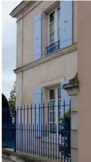
Corniche, bandeau, encadrements et soubassement en pierre de taille
