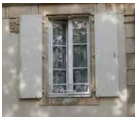
Volets battants en bois (ou éventuellement en aluminium) avec peinture de la même couleur que les volets
