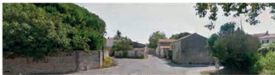
A l'entrée du village le bâti et la végétation se superposent
