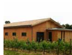
Isolation extérieure avec bardage en bois peint en cohérence avec l'enduit existant (ton clair)
