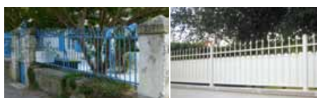
Grilles sur mur bahut, sans et avec festonnage
