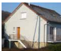
Isolation avec bardage en bois peint (ton clair)
