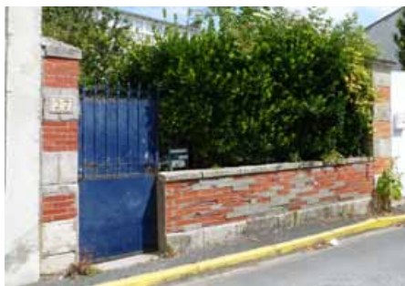
La clôture, constituée d'un muret surmonté d'une grille en fer forgée, fait aussi partie de cette architecture, qui donne à voir aux promeneurs
