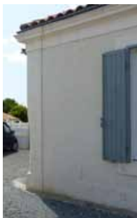
Corniche, chaînage, soubassement et encadrement en pierre de taille
