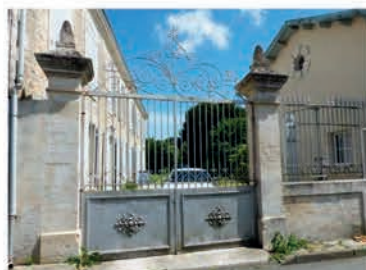
Muret surmonté d'une grille et portail encadré de piliers en pierre de taille et brique
