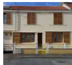
Isolation extérieure avec bardage en bois peint en cohérence avec l'enduit existant (ton clair)
