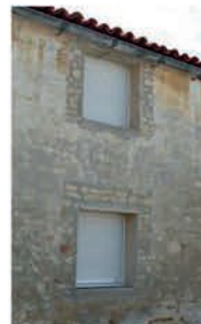
Le percements d'ouvertures aux proportions non adaptées et la réalisation d'enduits ciment
