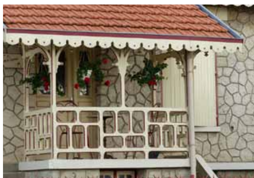
Marquise et porche en bois, marqueurs de l'entrée. Façade animée par de gros moellons en pierre et des encadrements où alternent brique et pierre
