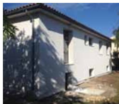
Isolation extérieure enduite avant / après
