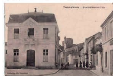
La rue Coyttar avec les anciennes halles, puis avec la nouvelle mairie
