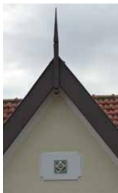
Le fronton est marqué de petits éléments de décors : nom de la villa, éléments en céramiques... La charpente est mise en valeur par un poinçon central et une planche de rive.
