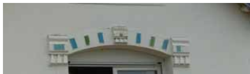
Linteau de fenêtre rehaussé par des éléments de céramique
