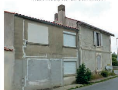
Le percements d'ouvertures aux proportions non adaptées et la réalisation d'enduits ciment
