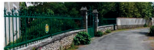
3 Mur bahut surmonté d'une grille
