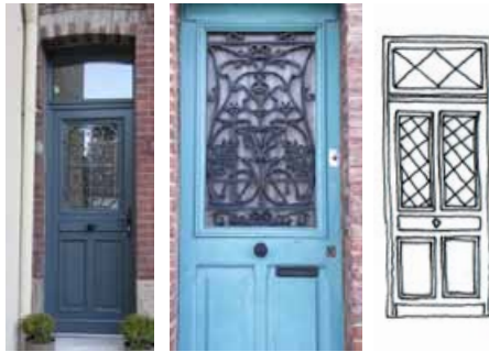
Différentes portes partiellement vitrées
