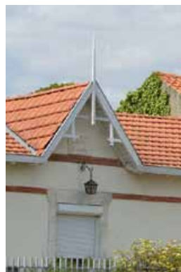
Le fronton est marqué de petits éléments de décors : nom de la villa, éléments en céramiques... La charpente est mise en valeur par un poinçon central et une planche de rive.
