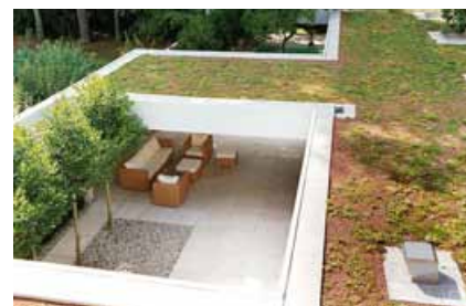
Toiture terrasse végétalisée
