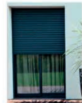
Volet roulant coloré avec coffre intégré à la maçonnerie, identique aux menuiseries
