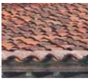
Egout de toiture avec chevrons dépassants
