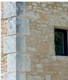
Chaînage en pierre de taille et enduit à pierre vue sur une façade de dépendance
