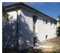
Isolation avec enduit
