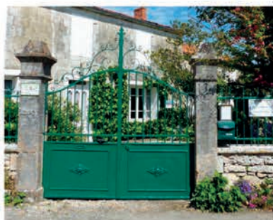
Muret surmonté d'une grille et portail encadré de piliers en pierre de taille et brique
