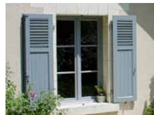
Volets battants en bois (ou éventuellement en aluminium) avec peinture de la même couleur que les volets
