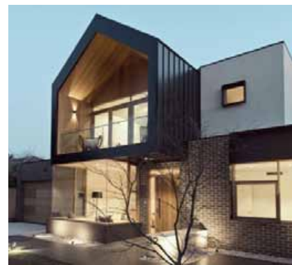
Architecture contemporaine avec décomposition des volumes. Toiture principale à deux pans et appendis en toiture terrasse.
