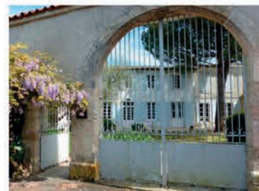
Portails accompagnés d'un portillon piéton
